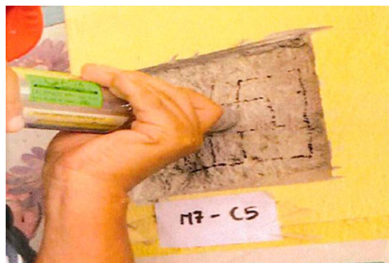
Figura 3. Remoción del tarrajeo, grilla y prospección con el esclerómetro – 2do piso. Fuente: Elaboración propia.
