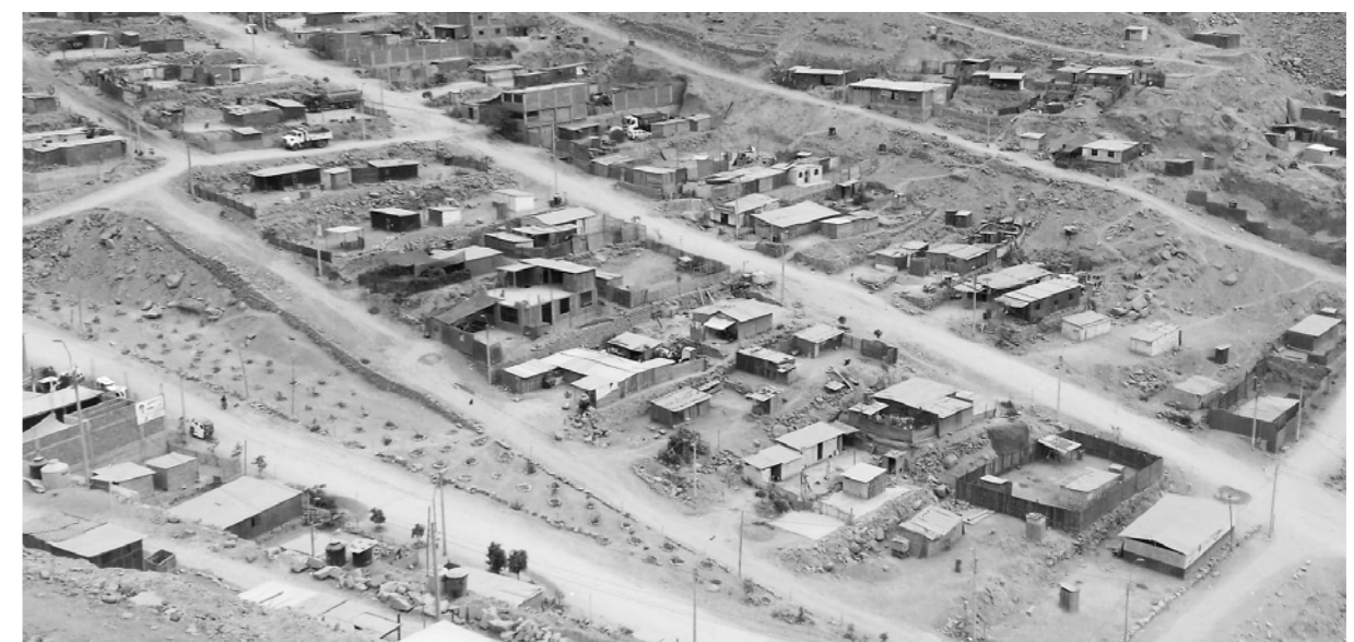
Figura 16. Asentamiento en las periferias, zona Z Huaycán. Fuente: Archivo Propio Una muestra de asentamiento informal precario que sucede en las periferias urbanas de la ciudad.
