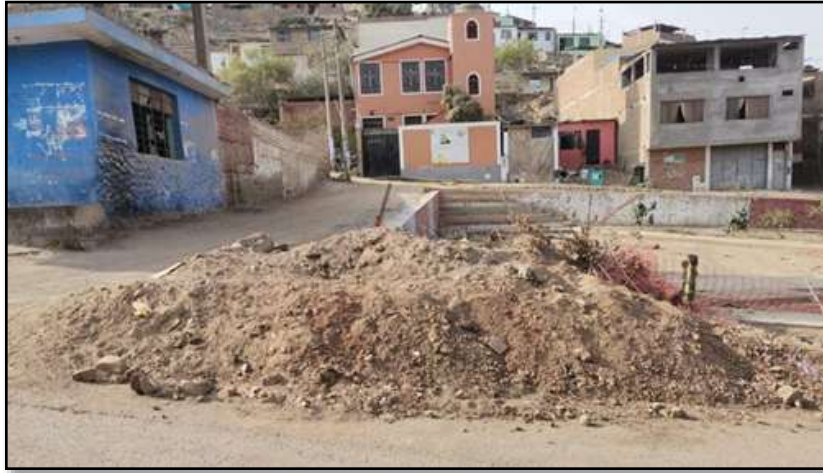
Figura N° 19: Acarreo y eliminación de material desmonte Fuente: Elaboración Propia
