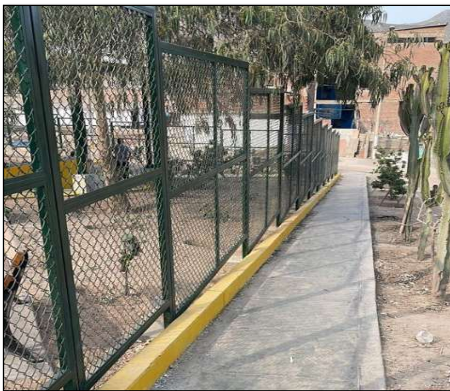
Figura N° 32: Adicional de Montaje y desmontaje de cerco y sardinel peraltado Fuente: Elaboración Propia
