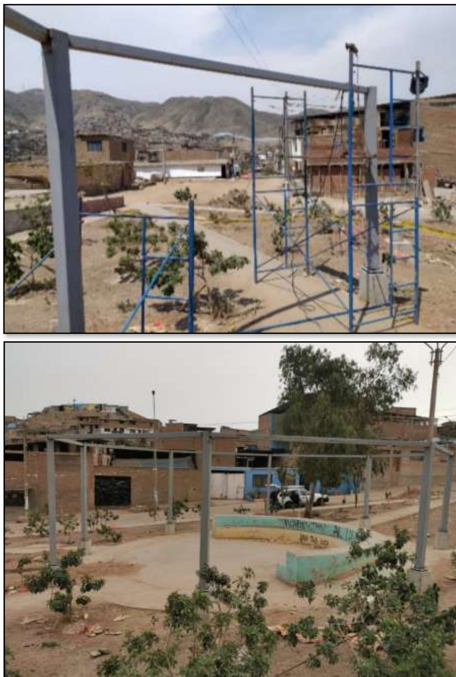
Figura N° 25: Instalación de vigas metálicas Fuente: Elaboración Propia
