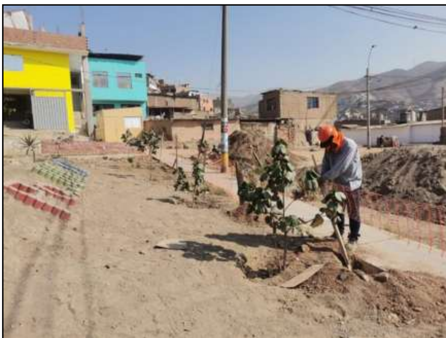
Figura N° 15: Excavación de zapatas para fijación de cerco perimétrico. Fuente: Elaboración Propia
