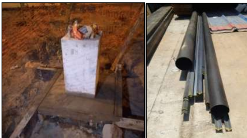
Figura N° 28: Suministro e instalación de asta de bandera. Fuente: Elaboración Propia
