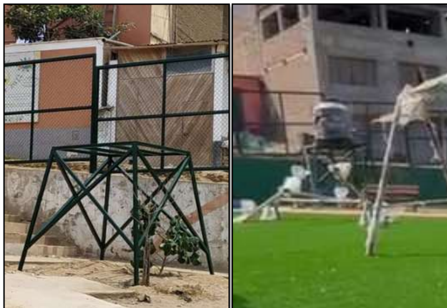
Figura N° 31: Instalación de tanque elevado. Fuente: Elaboración Propia
