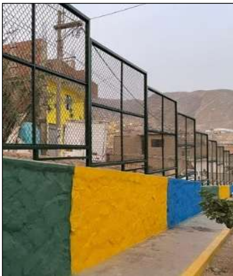
Figura N° 34: Partida adicional de pintado de muros internos en el parque. Fuente: Elaboración Propia
