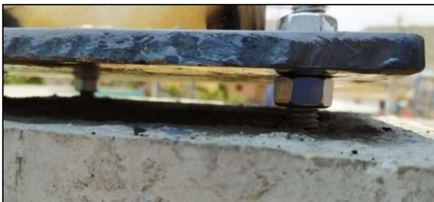
Figura N° 23: Colocación de la platina base de acero Fuente: Elaboración Propia
