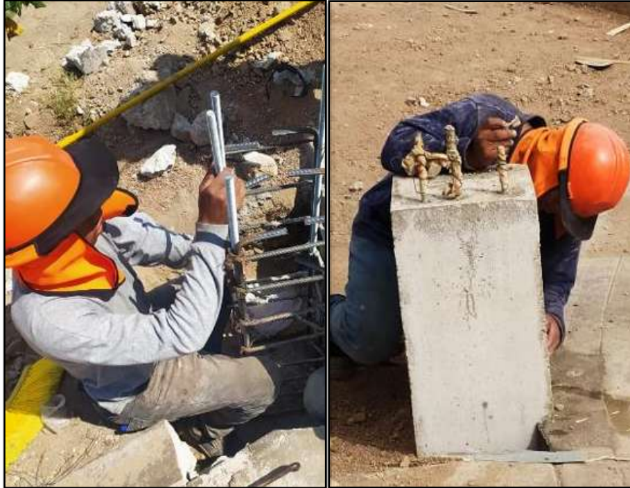
Figura N° 22: Trabajos en pedestal como base para mini anfiteatro. Fuente: Elaboración Propia
