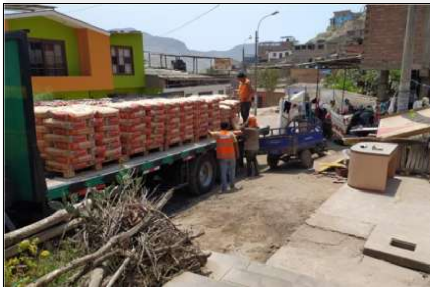
Figura N° 13: Movimiento de materiales en almacén y obra Fuente: Elaboración Propia
