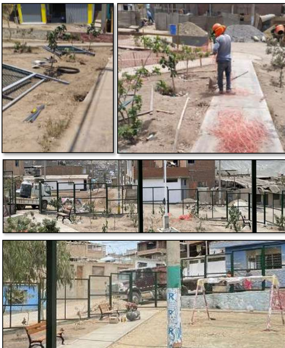
Figura N° 18: Vaciado de concreto en zapatas e instalación de cerco perimétrico. Fuente: Elaboración Propia
