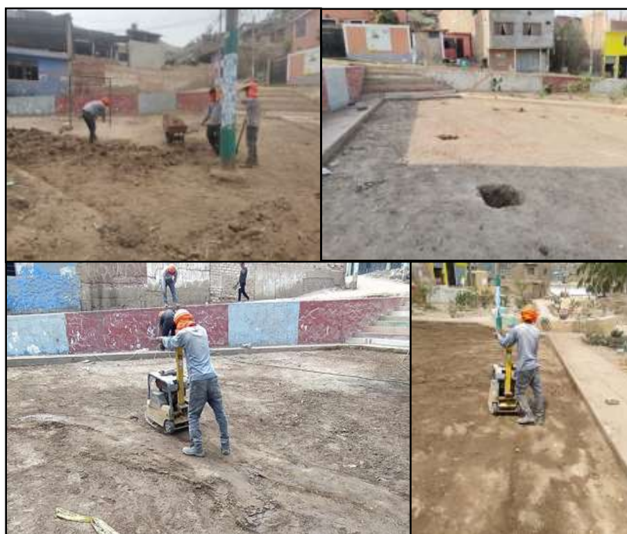
Figura N° 29: Nivelación y compactado para instalación de Grass sintético Fuente: Elaboración Propia
