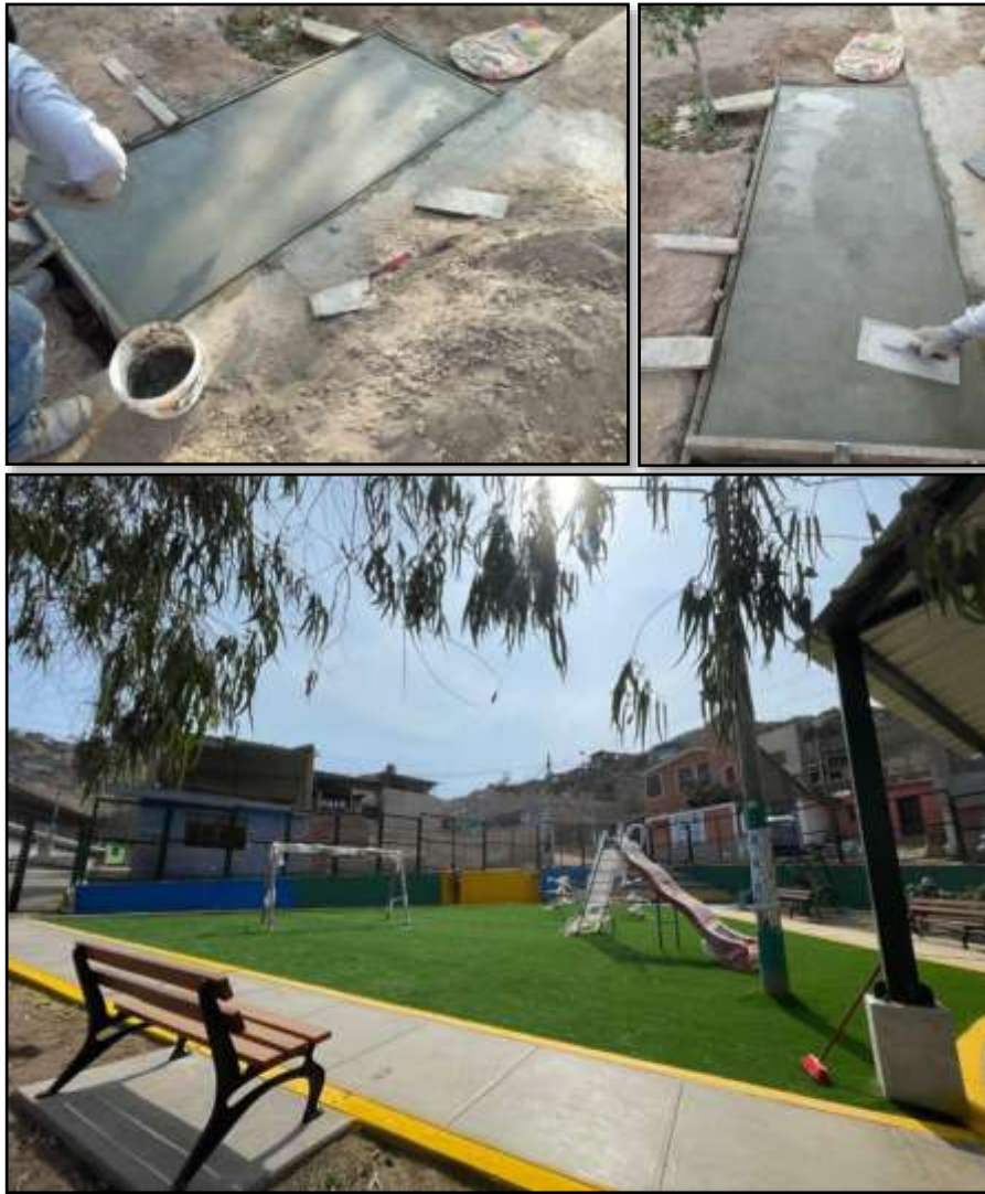
Figura N° 27: Trabajos para la construcción de bancas ornamentales. Fuente: Elaboración Propia
