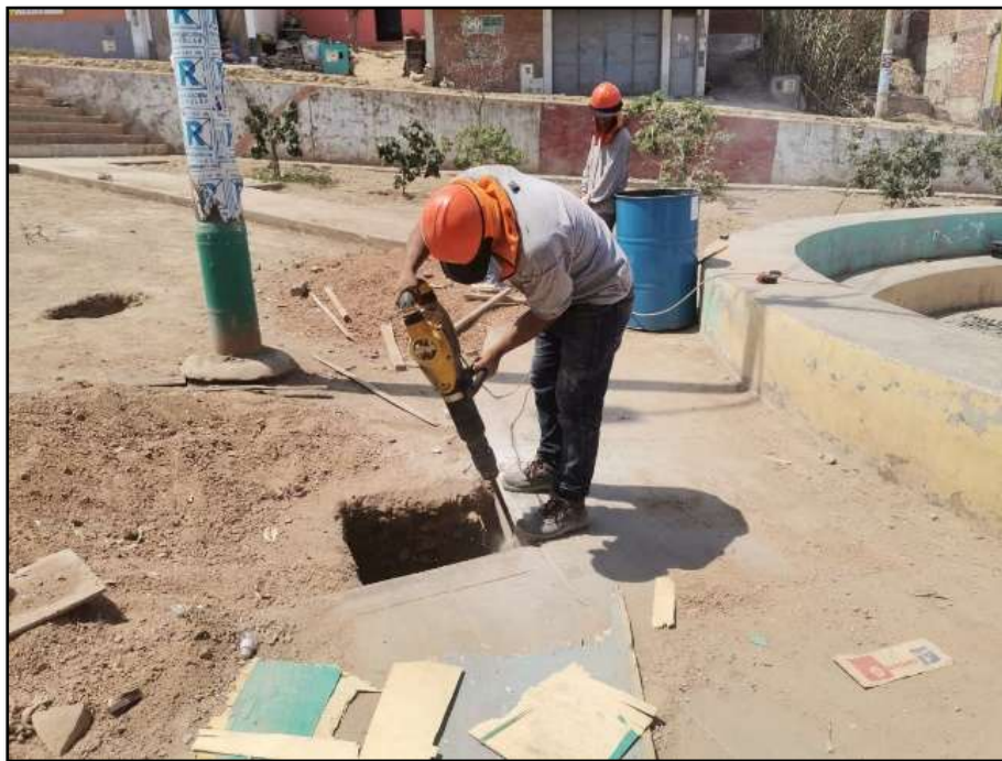
Figura N° 20: Excavación y corte para zapatas en mini anfiteatro Fuente: Elaboración Propia
