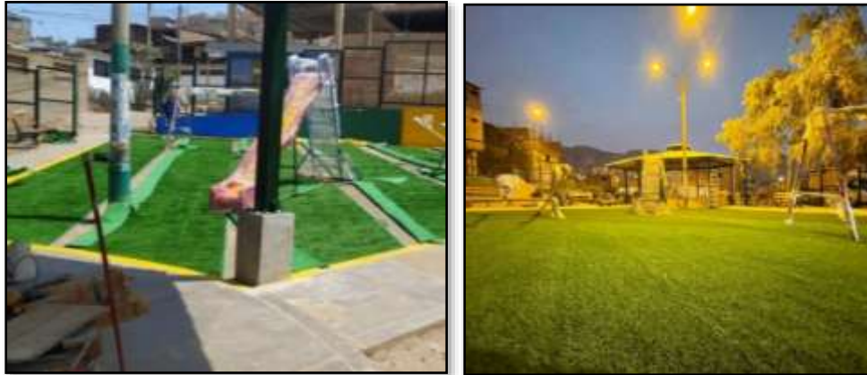
Figura N° 30: Instalación de Grass sintético y juegos metálicos para niños. Fuente: Elaboración Propia
