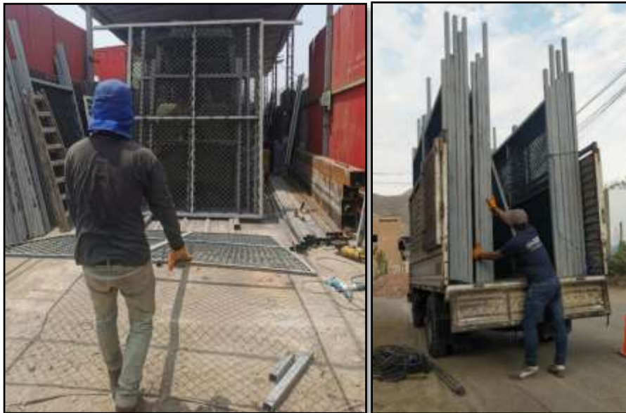
Figura N° 17: Pintado de cerco perimétrico y traslado al lugar de la obra. Fuente: Elaboración Propia
