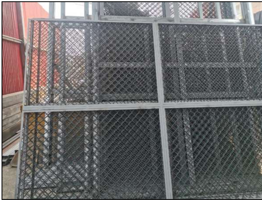
Figura N° 16: Habilitación de malla galvanizada en taller. Fuente: Elaboración Propia
