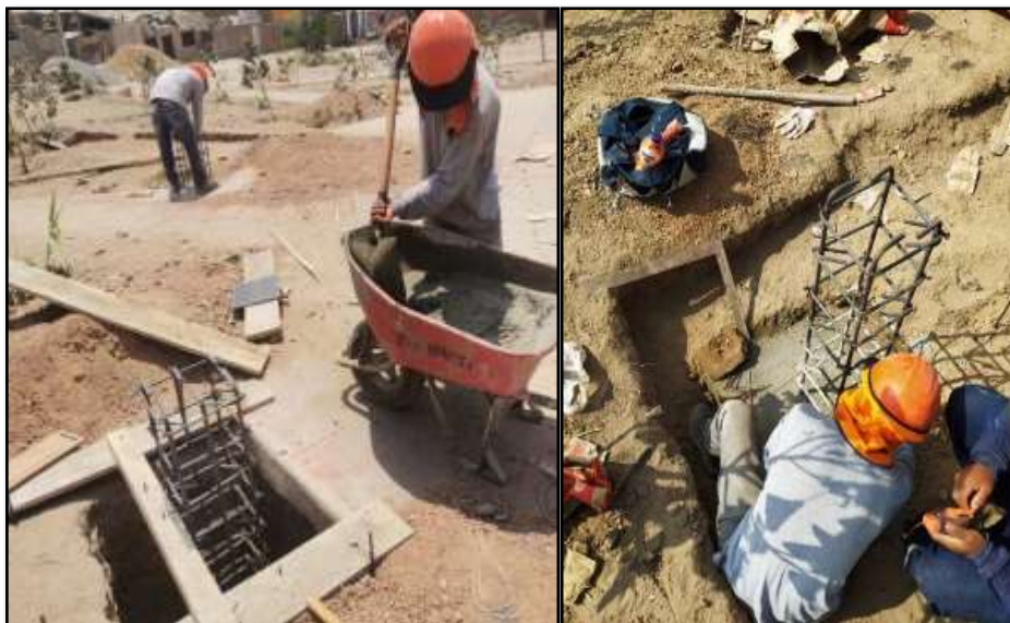
Figura N° 21: Trabajos en zapata como base para mini anfiteatro. Fuente: Elaboración Propia
