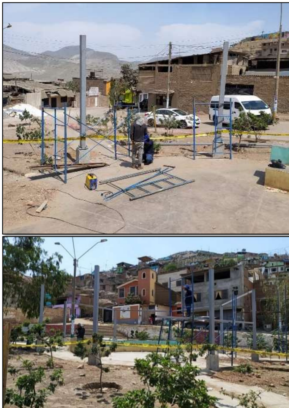
Figura N° 24: Izamiento de las columnas metálicas cuadradas Fuente: Elaboración Propia
