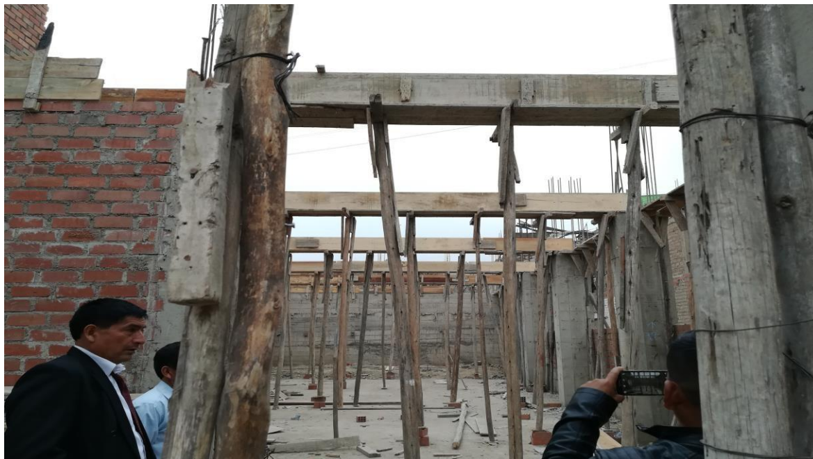
Anexo 21. Encofrado del templo.
