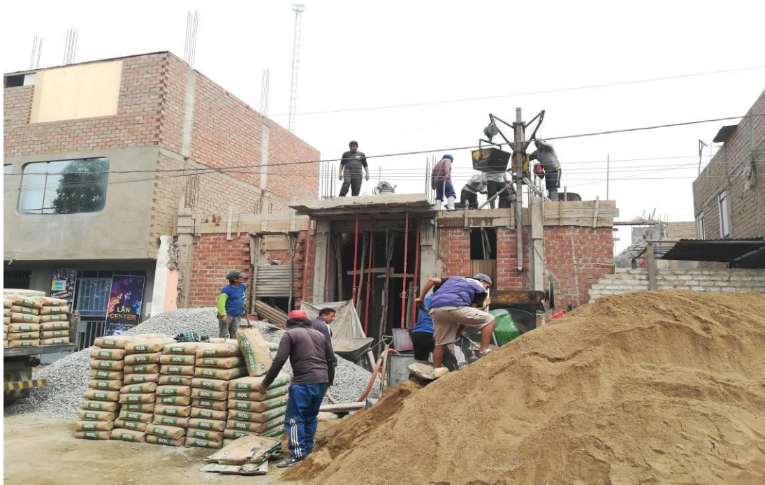
Anexo 24. Vaciado de Losa.
