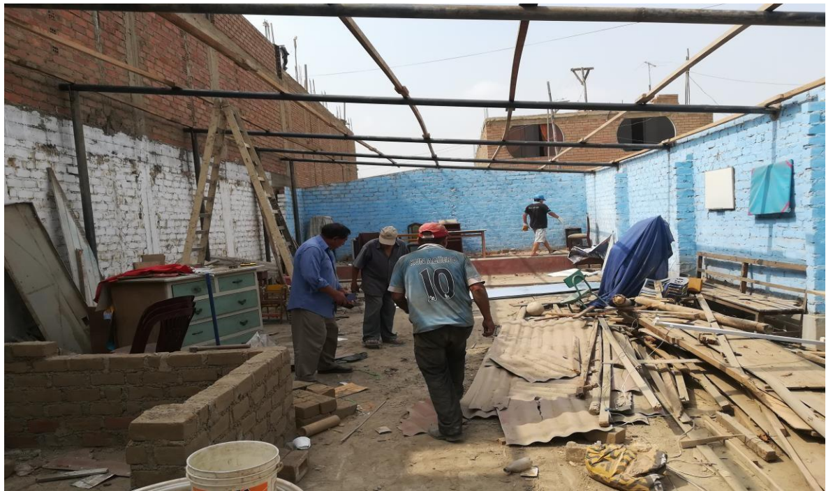
Anexo 12. Inicio de Demolición.
