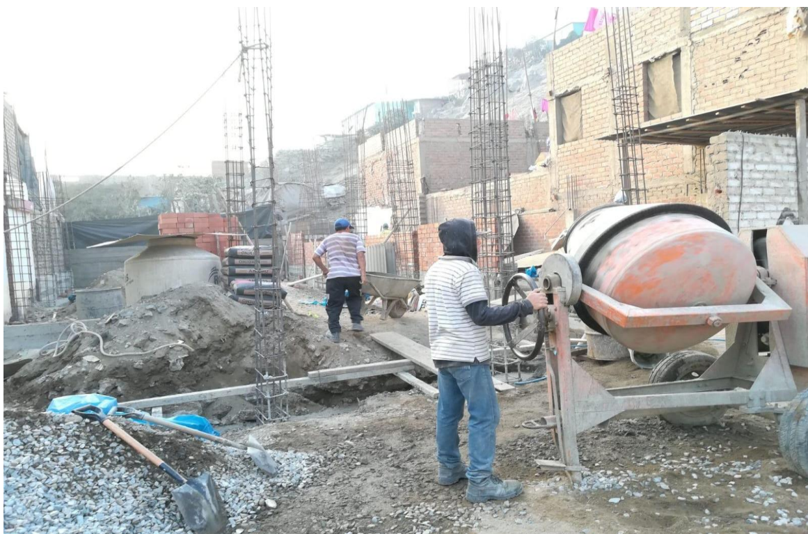
Anexo 18. Avance de la construcción del templo.
