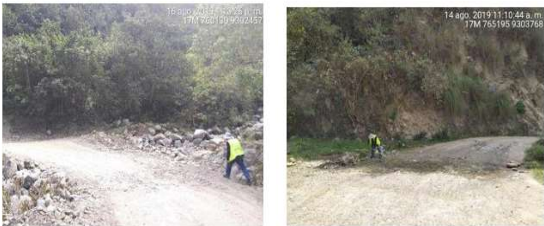
Figura N° 33 Estructuras de Baden existente. Fuente: Conalto SAC.
