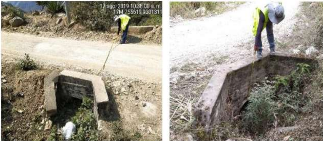
Figura N° 32 Estructuras de alcantarilla existente. Fuente: Conalto SAC.
