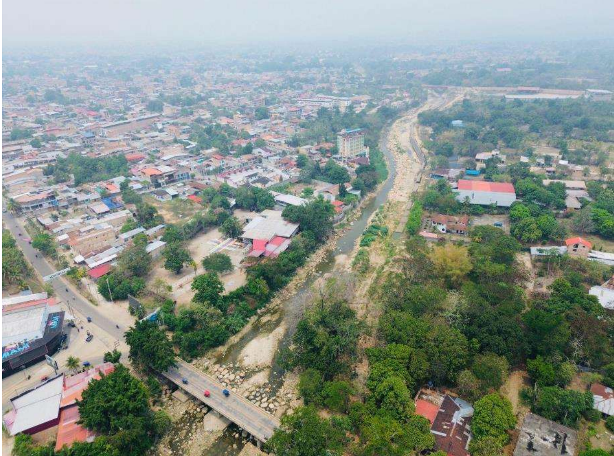
Figura 5. Vista aérea de la zona de influencia al puente Cumbaza (2024). Fuente: Elaboración propia.
