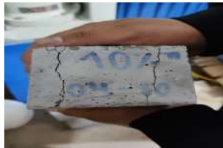
Figura 8. Rotura de adoquín vista lateral
