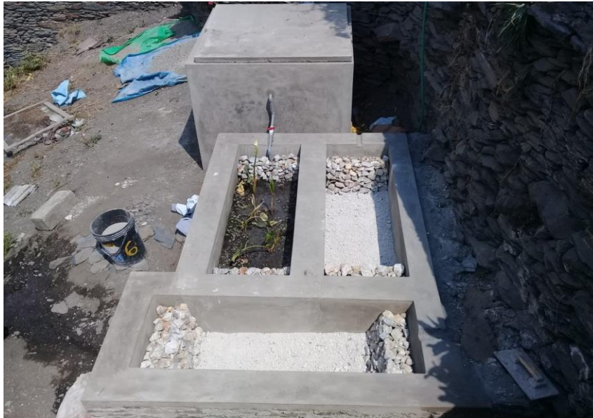
Figura 11: Colocación de la arena fina
