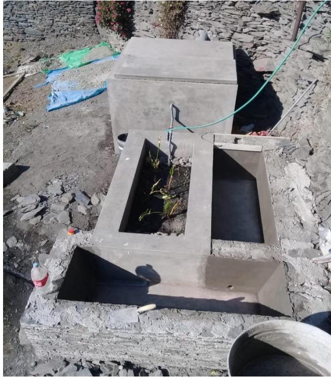
Figura 9: Construcción de los humedales
