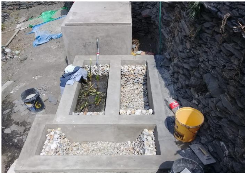
Figura 10: Colocación de la grava
