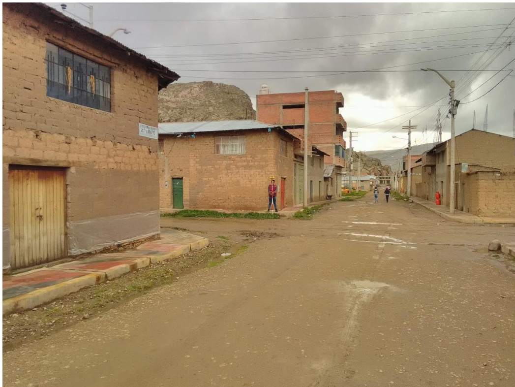
Fotografía N° 6.- Urbanización Santa Cruz
