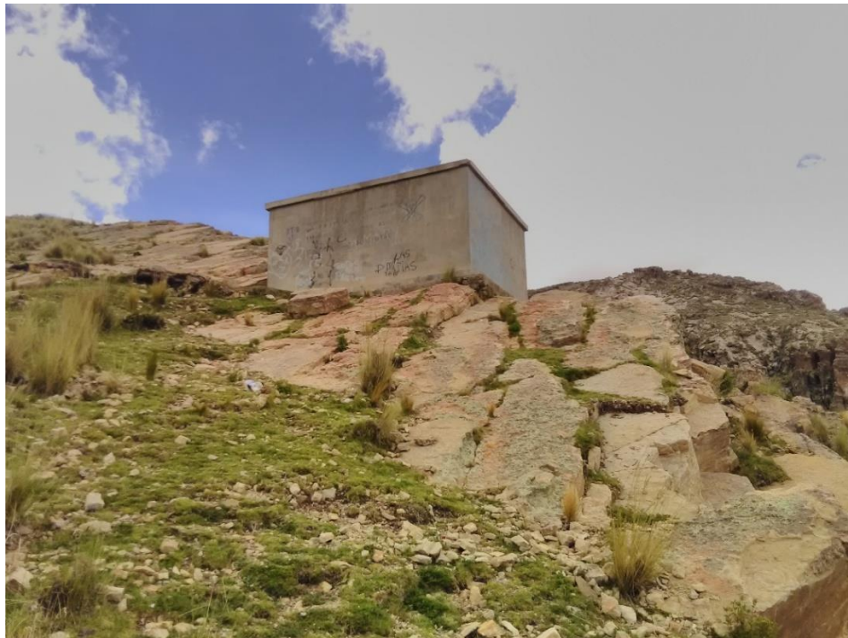
Fotografía N° 2.- Reservorio capacidad 60m 3 .
