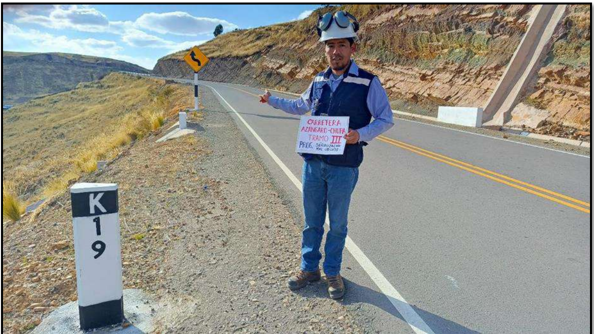
FOTOGRAFIA N° 09: EN LA IMAGEN SE MUESTRA LA AUSENCIA DE SEÑALIZACION INFORMATIVA (CURVA PELIGROSA) EN LA PROGRESIVA 18+260.
