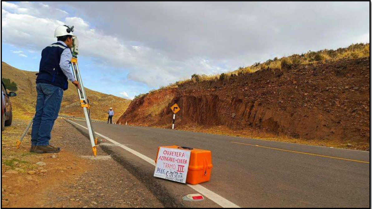
FOTOGRAFIA N° 15: EN LA IMAGEN SE MUESTRA LA OBTENCION DE LAS LONGITUDES DE TANGENTES MINIMAS ADMISIBLES Y MAXIMAS DESEABLES EN LOS TRAMOS EN TANGENTE CON EL EQUIPO TOPOGRAFICO ESTACION TOTAL.
