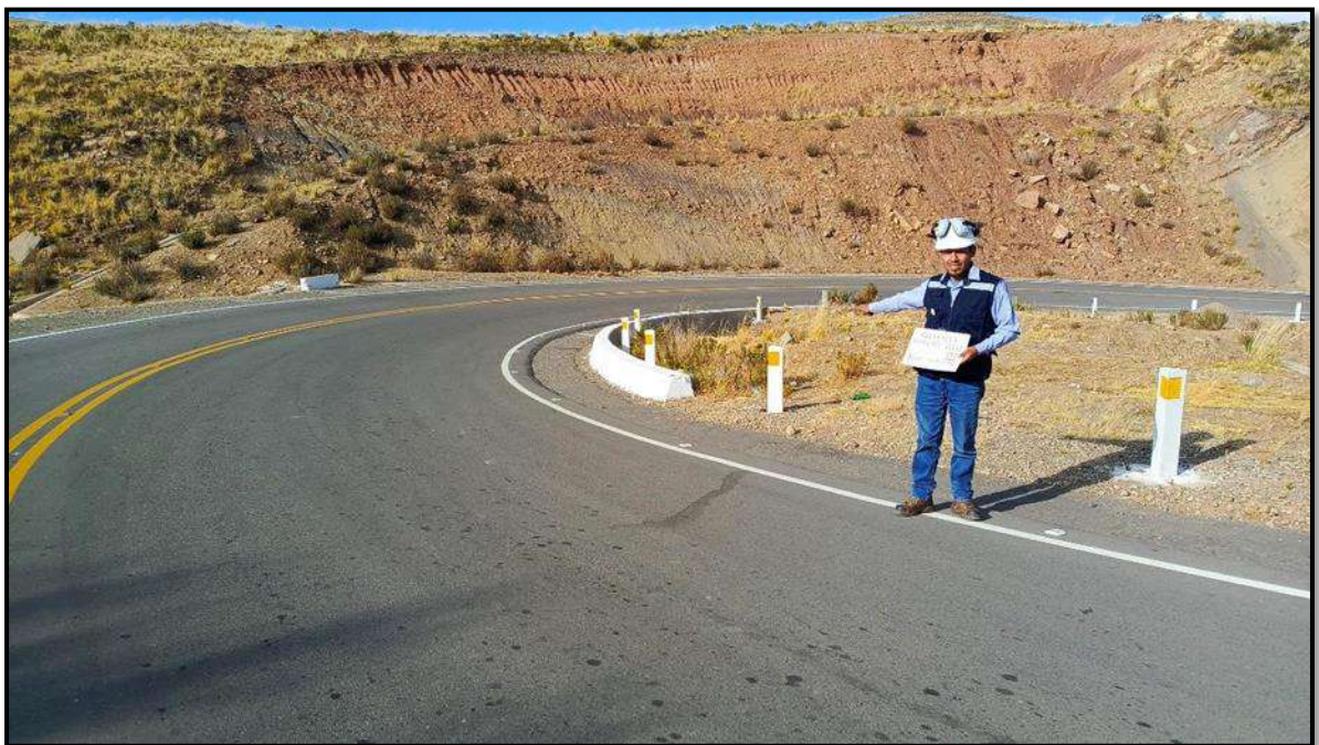
FOTOGRAFIA N° 07: EN LA IMAGEN SE MUESTRA EL SOBRECANCHO EN LA PROGRESIVA 18+360.
