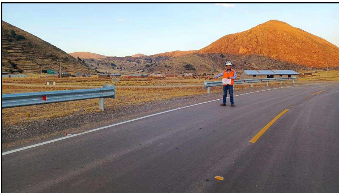
FOTOGRAFIA N° 18: EN LA IMAGEN SE MUESTRA LA AUSENCIA DE SEÑALIZACION DE PREVENCION (P-9B).
