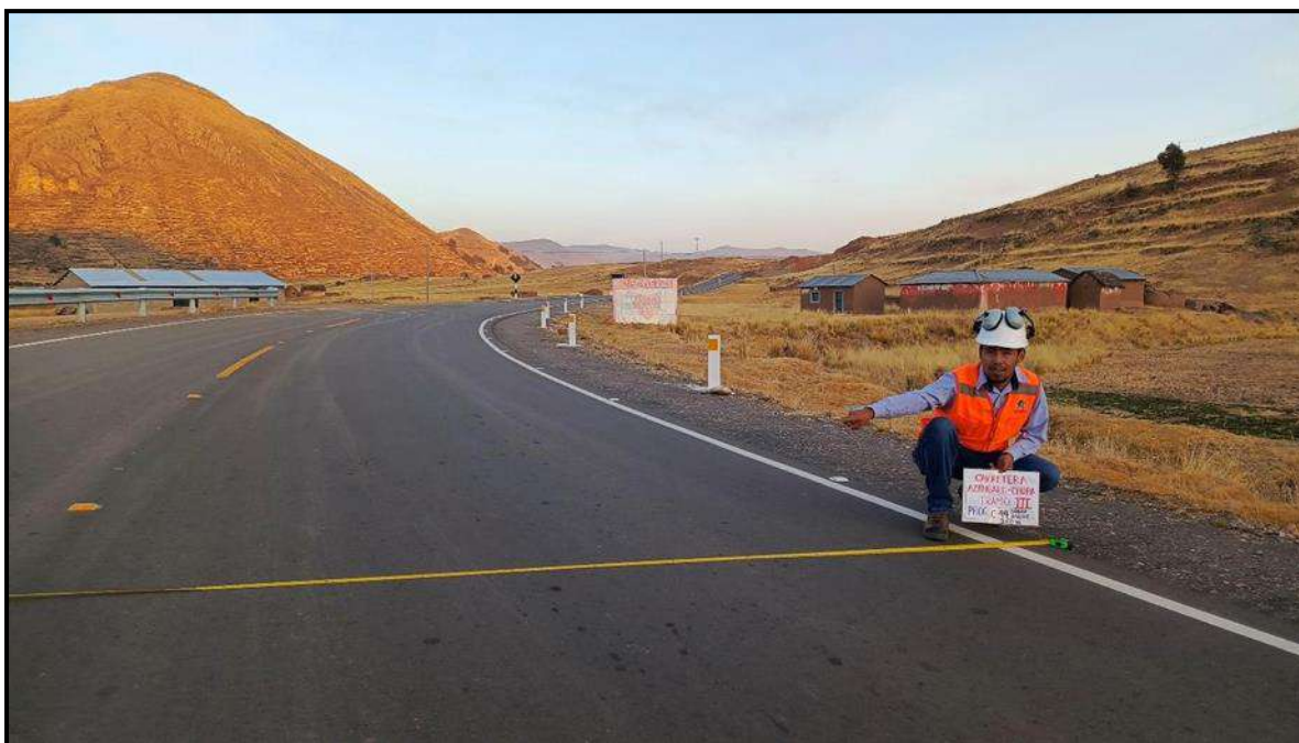
FOTOGRAFIA N° 17: EN LA IMAGEN SE MUESTRA LA MEDIDA DEL SOBREALCHO EN LA PROGRESIVA 20+380.
