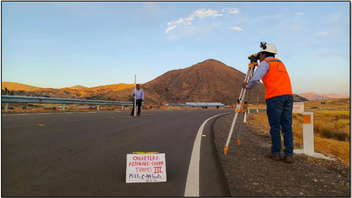
FOTOGRAFIA N° 21: EN LA IMAGEN SE MUESTRA LA OBTENCION DEL PERALTE EN LA PROGRESIVA 19+330. CON EL EQUIPO TOPOGRAFICO ESTACION TOTAL.
