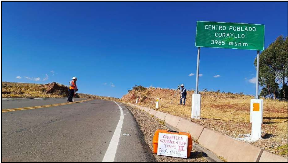
FOTOGRAFIA N° 01: EN LA IMAGEN SE MUESTRA EL PUNTO DE INICIO DE LA CARRETERA TRAMO III CURAYLLO CHUPA PROGRESIVA 17+100, DONDE SE ESTA COMPROBANDO EL LEVANTAMIENTO DE INFORMACION PARA EL DESARROLLO DEL ANALISIS DEL DISEÑO GEOMETRICO CON EL EQUIPO DE ESTACION TOTAL.
