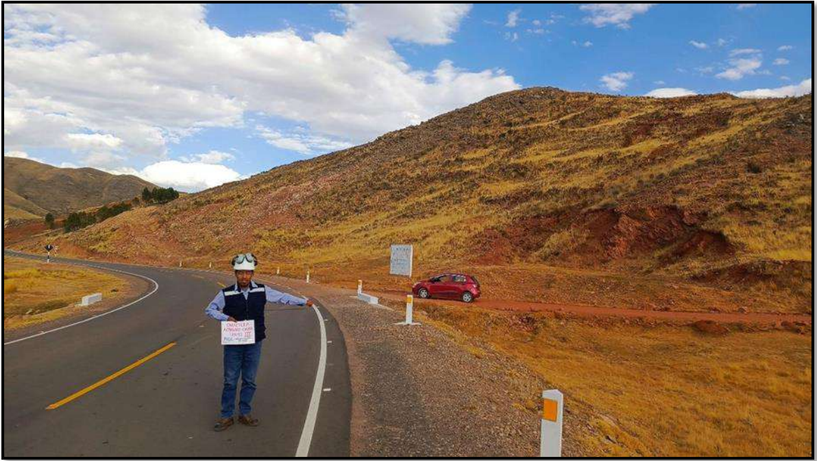
FOTOGRAFIA N° 13: EN LA IMAGEN SE MUESTRA LA AUSENCIA DE SEÑALIZACION DE PREVENCION (P-16A) EN LA PROGRESIVA 21+000.
