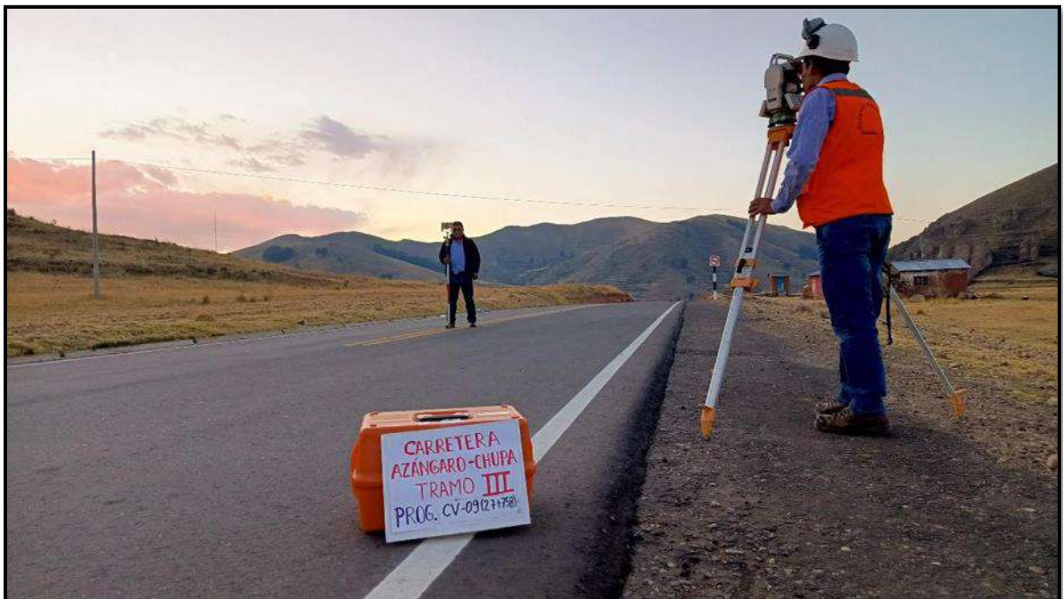
FOTOGRAFIA N° 20: EN LA IMAGEN SE MUESTRA LA OBTENCION DE LAS LONGITUDES DE LA DISTANCIA DE ADELANTAMIENTO EN CURVAS VERTICALES CON EL EQUIPO TOPOGRAFICO ESTACION TOTAL.
