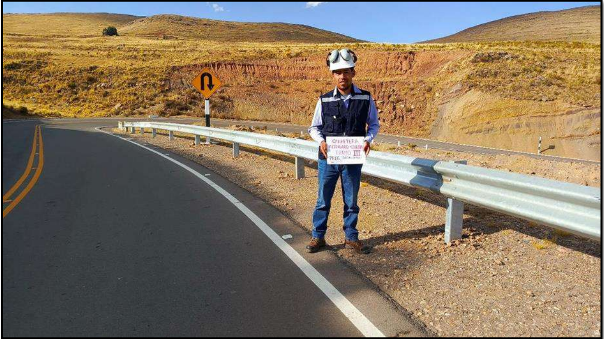
FOTOGRAFIA N° 09: EN LA IMAGEN SE MUESTRA LA AUSENCIA DE SEÑALIZACION INFORMATIVA (CURVA PELIGROSA) EN LA PROGRESIVA 18+260.
