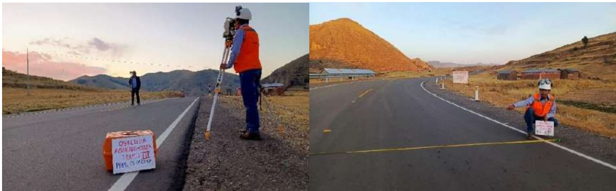
Fig. 3. En la imagen se muestra la comprobación del sobreancho y peralte en la progresiva km 20+380.
