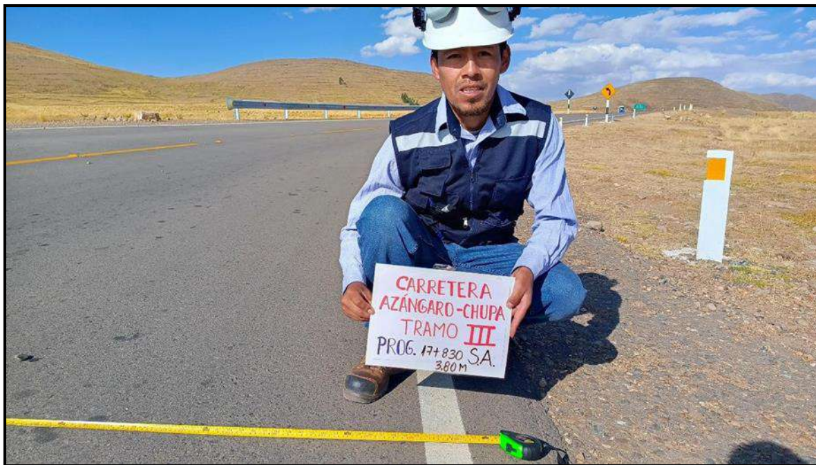
FOTOGRAFIA N° 03: EN LA IMAGEN SE MUESTRA LA MEDIDA DEL SOBREALCHO EN LA PROGRESIVA 17+830.
