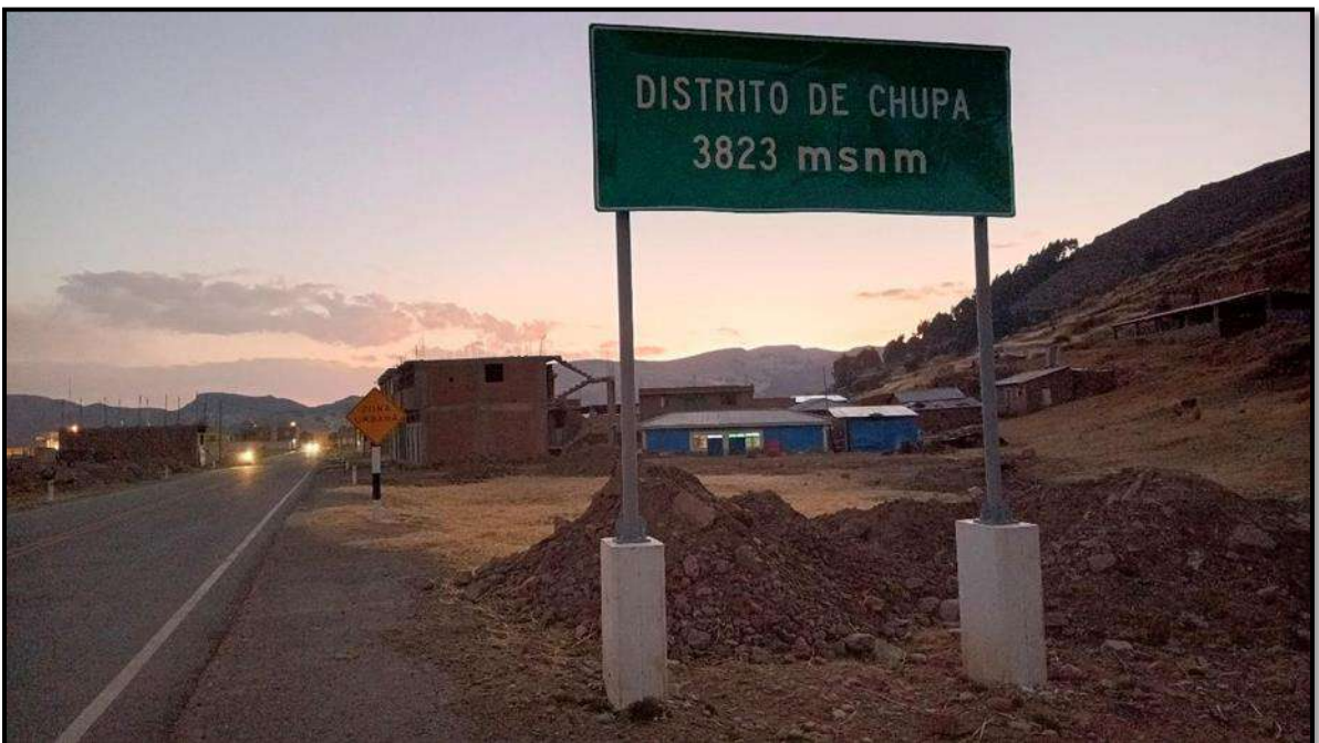
FOTOGRAFIA N° 22: EN LA IMAGEN SE MUESTRA EL FINAL DE LA CARRETERA TRAMO III CURAYLO - CHUPA.
