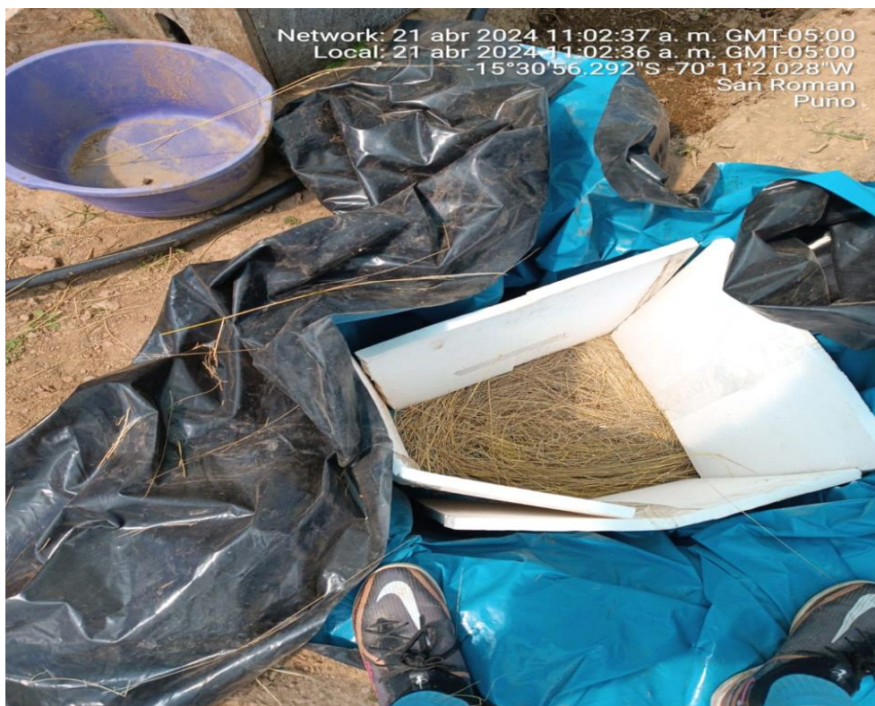
Figura 7: Aislamiento del tanque central con pajonal andino y tecnopor
