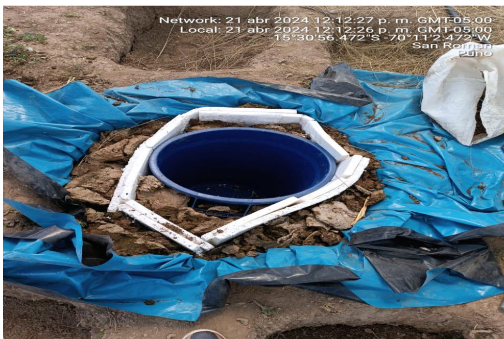
Figura 8: Tanque central aislado con estiércol vacuno
