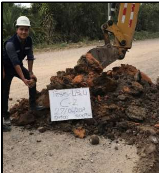
Apertura de calicata C-2 (Fecha de exploración 27/06/2019)
