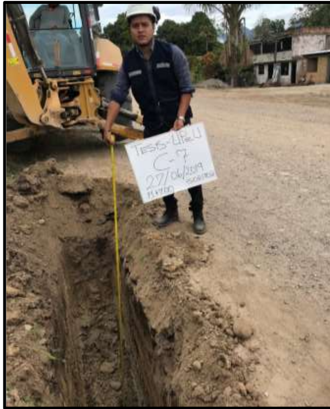
Figura N° 3-3 Apertura de calicata C-7 – Presencia de arcilla a nivel superficial
