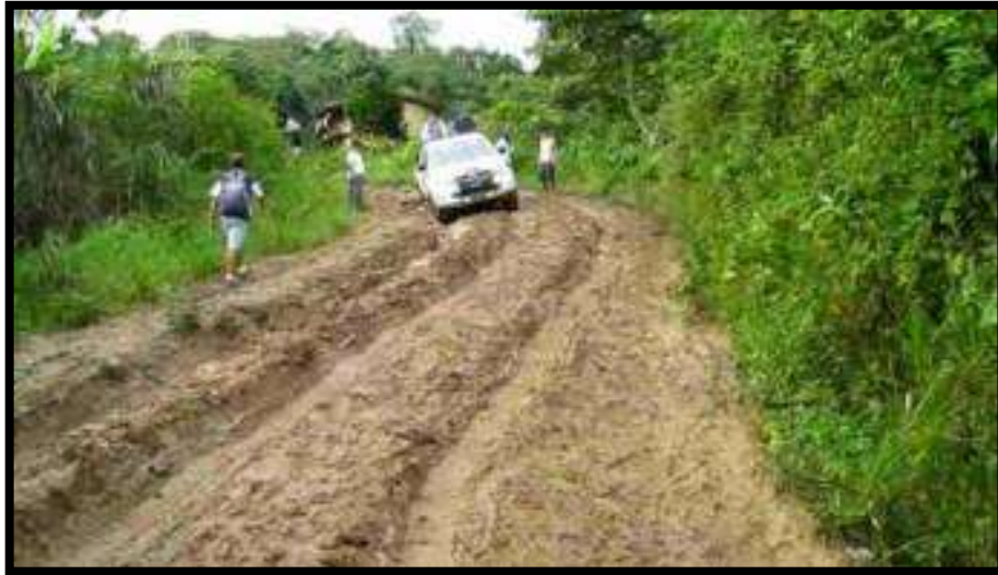
Figura N° 1-1 Estado de carretera en temporada de lluvia
