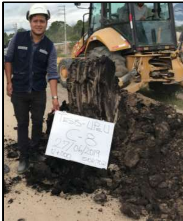
Apertura de calicata C-8 presencia de arcilla oscura (Fecha de exploración 27/06/2019)
