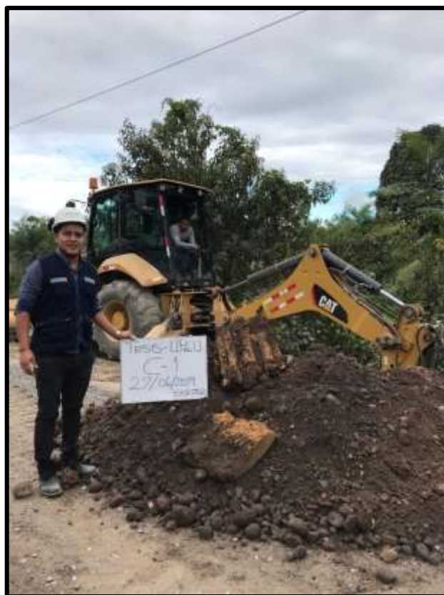
Muestreo en calicata C-1 Presencia de material grava limo arcillosa en el primer metro de profundidad (Fecha de exploración 27/06/2019)
