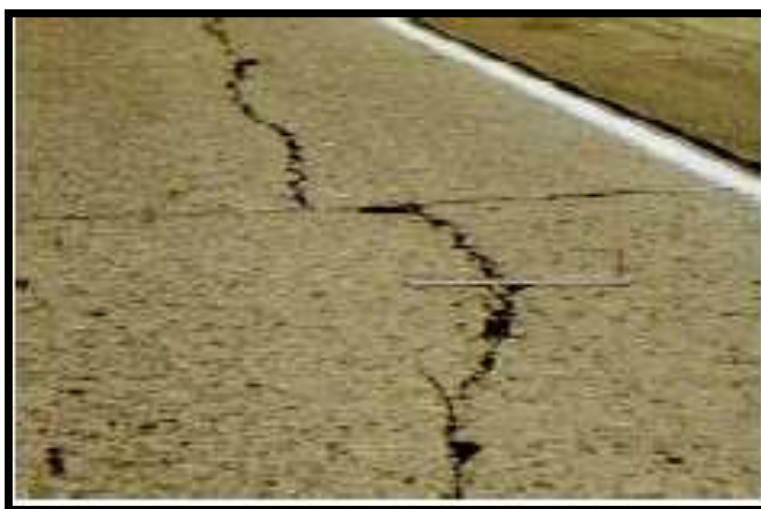
Figura N° 2-5 Grietas longitudinales
