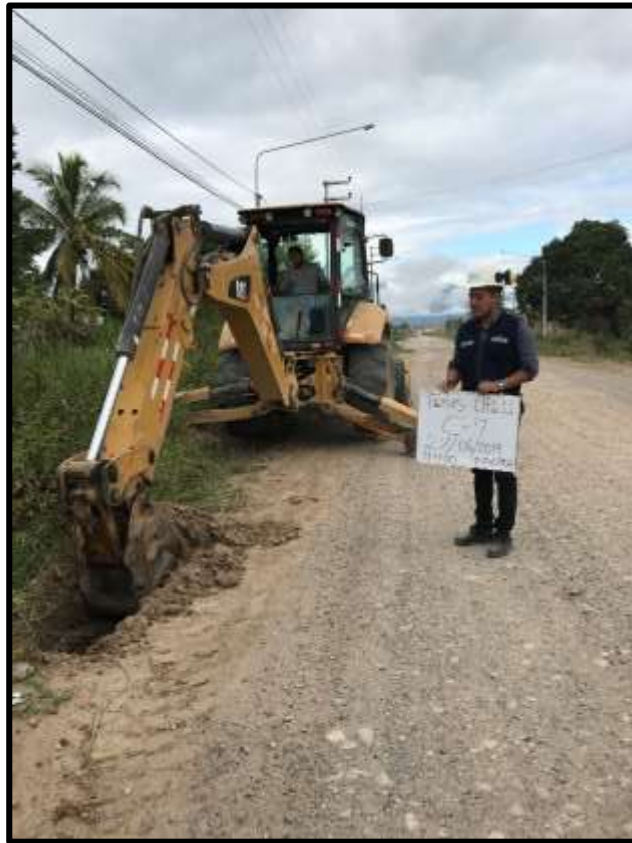
Apertura de calicata C-7 con Retroexcavadora (Fecha de exploración 27/06/2019)
