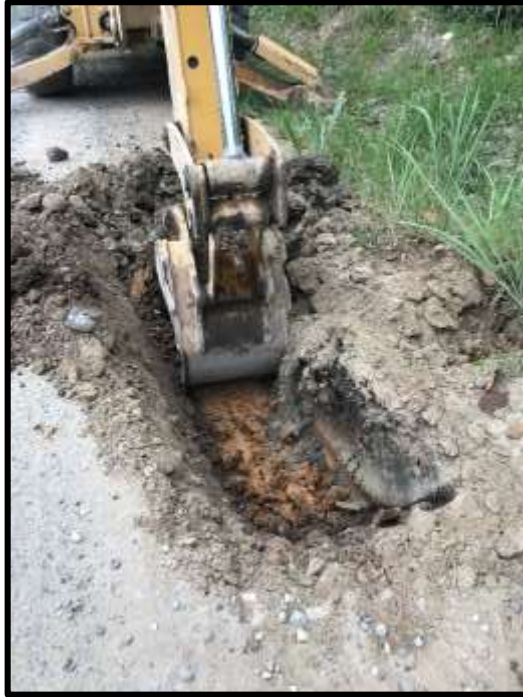
Apertura de calicata C-3 (Fecha de exploración 27/06/2019)
