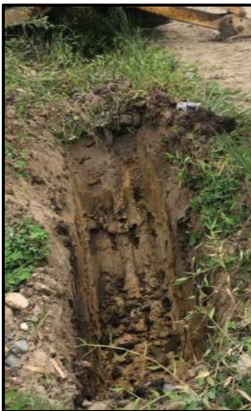
Apertura de calicata C-6 – Presencia de arcilla amarillenta (Fecha de exploración 27/06/2019)
