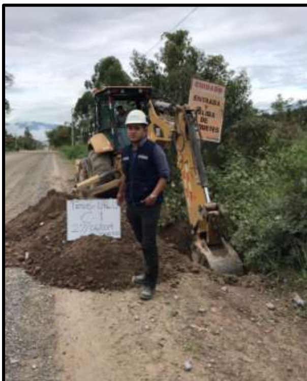
Apertura de calicata C-1 (Fecha de exploración 27/06/2019)
