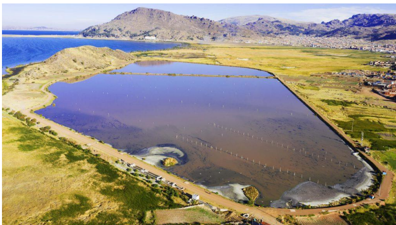
Figura 2. Vista de la laguna de oxidación, Isla Espinar Fuente: Proyecto PTAR Titicaca
