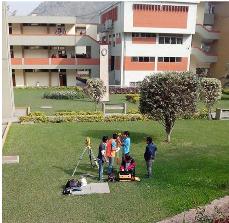
Figura 58 - Pabellón C con su tercer piso, 2010.
