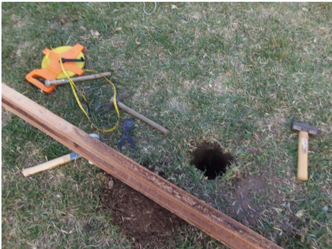
Figura 17 - Excavación en el terreno
