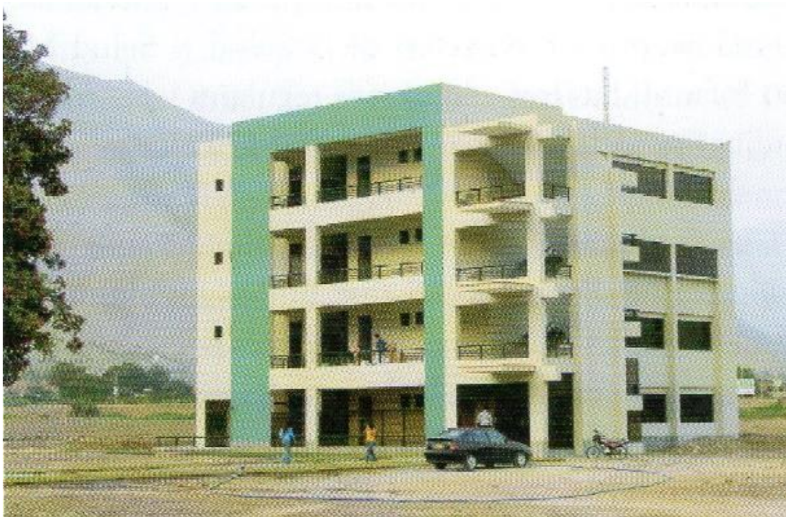
Figura 44 - Laboratorios de computación y las instalaciones de DIGESI
