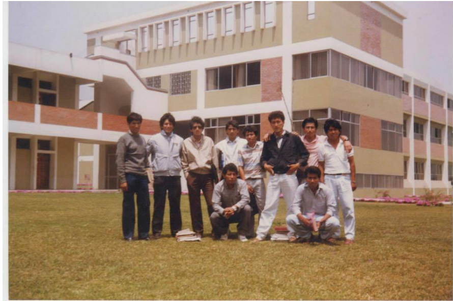
Figura 57 - Pabellón C y pabellón B. Actualmente el pabellón C cuenta con 3 pisos y el B con 4 pisos.
