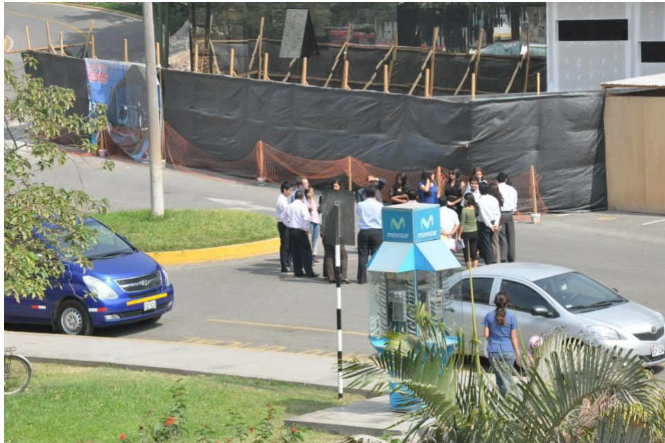
Figura 69 - Construcción de la nueva librería
